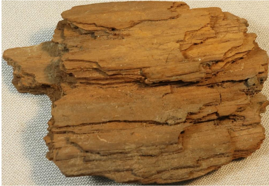
Рис. 33 – Деревянное перекрытие. Танкеевский могильник, 1961г. Усушка и трухлявость древесины; растрескивание вдоль волокон древесины; отслоение волокон древесины. Фотография Д.Ф. Хабибуллиной.
